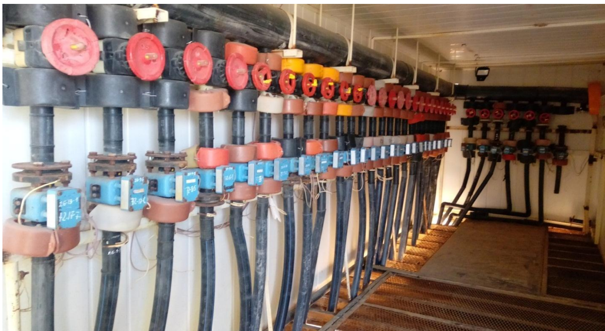
10 Сурет – Жүктеу ұңғымаларының ТУРР-ға жалғануы.
