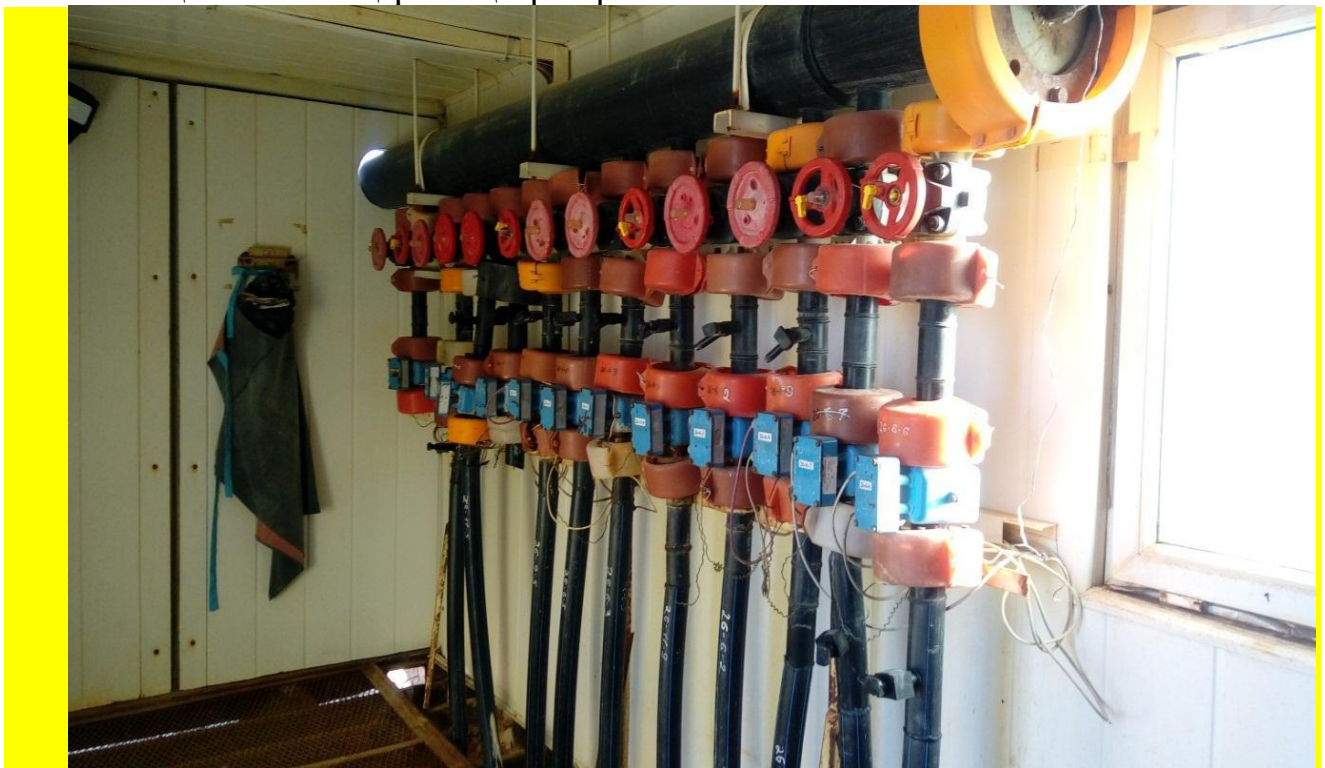
9 Сурет – Сорғыту ұңғымаларының ТУРР-ға жалғануы
